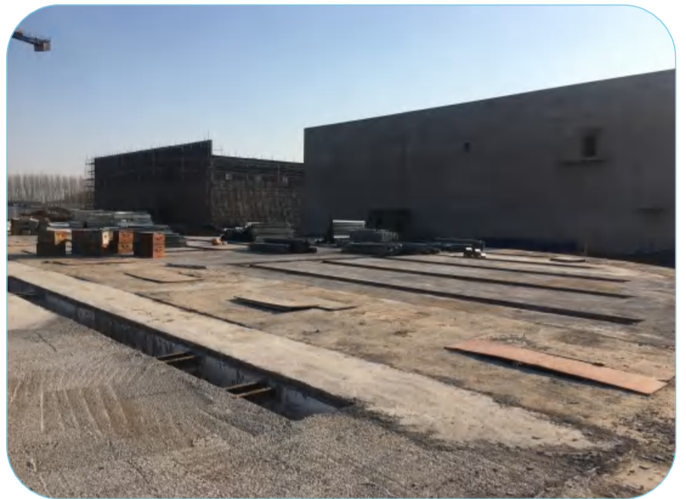
由龙安集团承建的绥化市新和成项目正在紧张施工中,工程内容为钢结构、设备、管道、电气、仪表等,计划于今年 6 月 1 日交付。项目部的施工质量和科学管理得到了建设单位、监理单位的充分肯定,在新和成 10 个施工单位安全质量评比中,多次喜创佳绩,并成功签订了后续工程合同。
