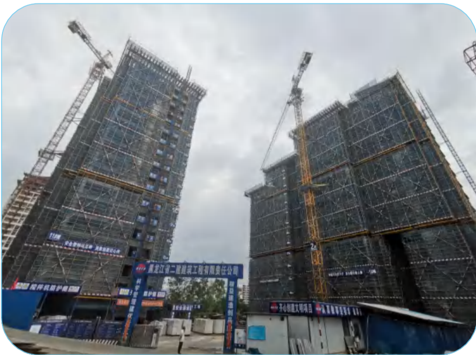
由建工集团二建公司承建的保亭野奢世界三期 11#、13# 住宅区工程,目前进行到主体砌筑阶段,项目位于海南省保亭县,建筑面积约 24327.39 平米,建筑层数 19 层,是集商务、旅游、休闲度假、居住为一体的多功能智能小区。该项目为二建公司的自营项目,依靠项目品牌效应吸引合作伙伴,并通过精细化的项目管理和良好的跟踪服务承接了后续工程。
